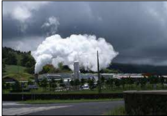
Figura 6 - Usina Geotérmica - Portugal
