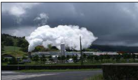
Figura 6 - Usina Geotérmica - Portugal
