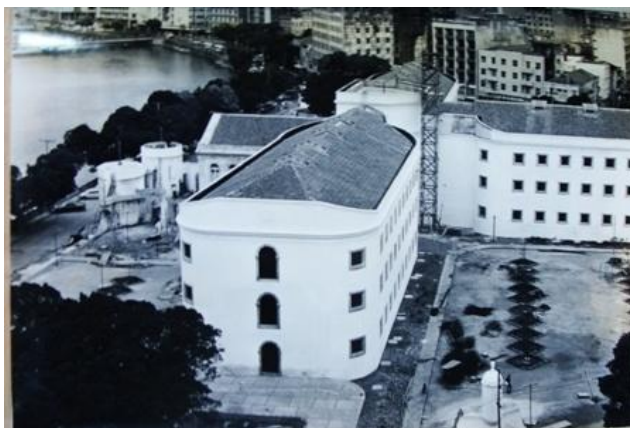
Figura 04 – Antiga Casa de Detenção do Recife
