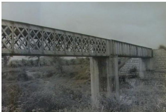
Figura 21 – Trecho ferroviário entre Recife e Gravatá
