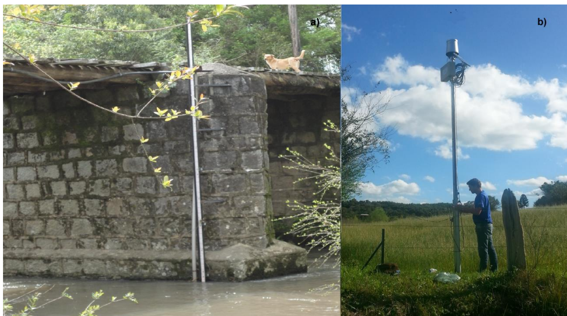
Figura 15 - Ilustração da seção de controle do arroio Cadeia com a estrutura para monitoramento automático de nível d'água e também por réguas linimétricas (a); e da unidade de aquisição e armazenamento de informações hidrológicas de chuva e de nível da estação modelo Solar SL2000-PNVn, da mesma seção (b)
