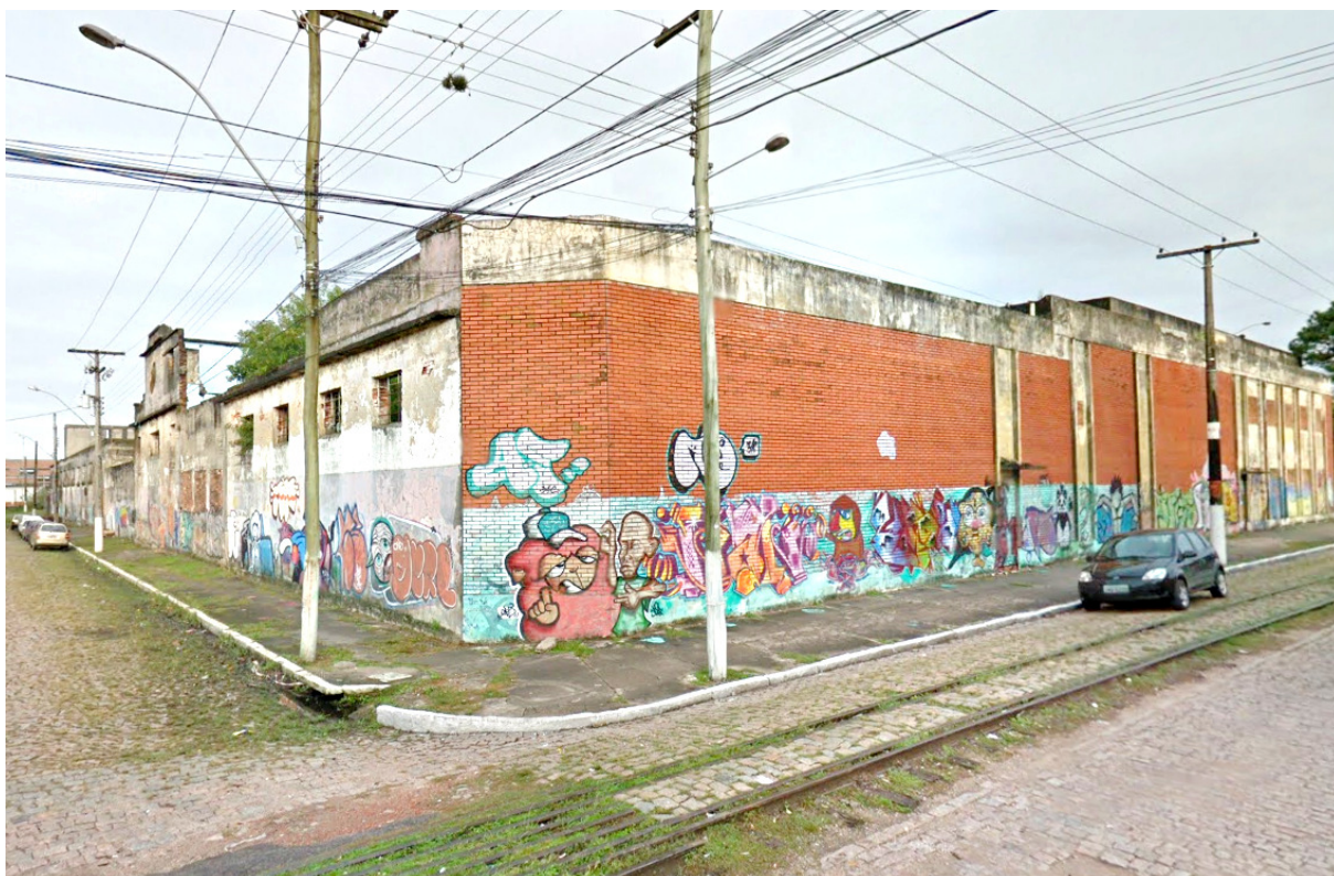
Figura 36 – Aspecto de edifício antes do festival de graffiti Spray'sons . Pelotas, 2011. Fonte: Google, 2017.
