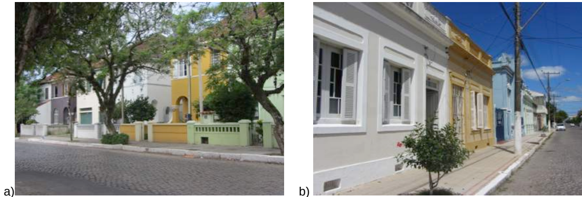
Figura 4.1 | Imagens do bairro Porto. Prédios residenciais na Rua Almirante Barroso (a) e na Rua Benjamin Constant (b) Fonte: fotos da autora, 2013.
