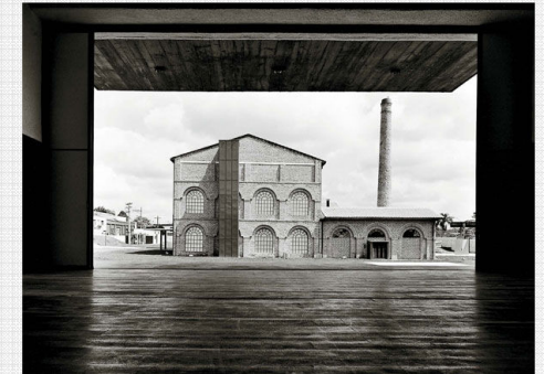
Figura 01 - Conjunto KKKK (Registro, São Paulo, Brasil Arquitetura, 1996-2001). Fonte: www.brasilarquitetura.com .
