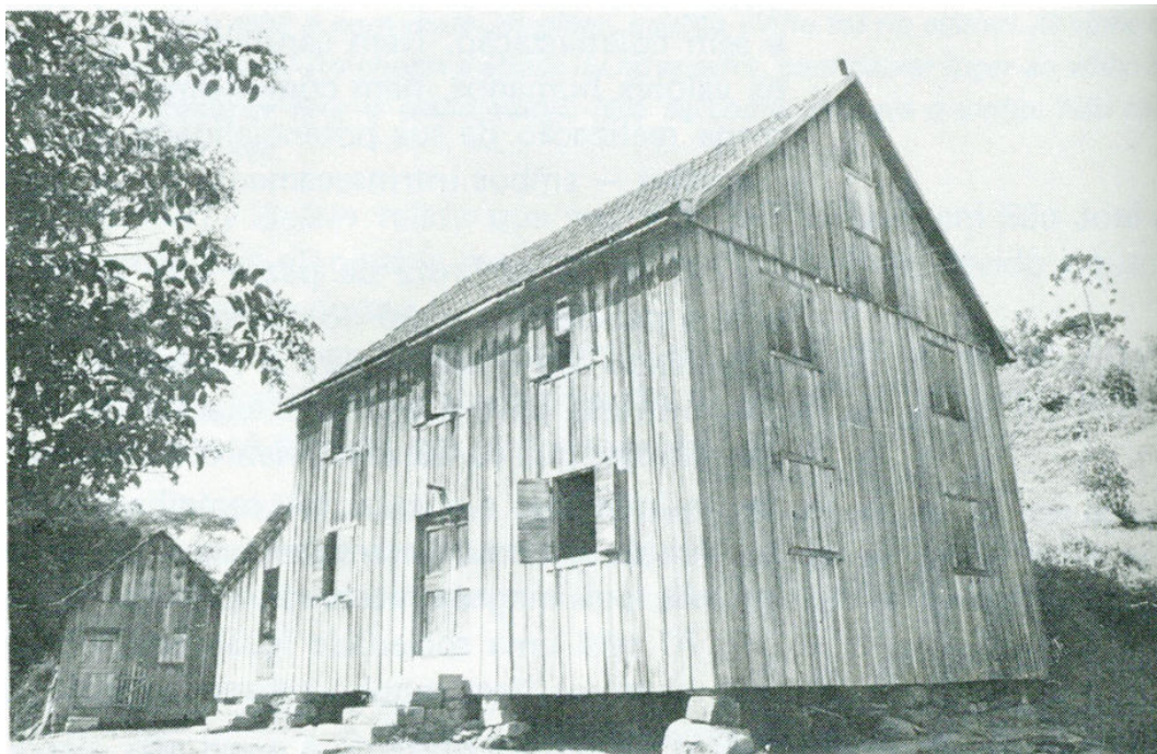
Figura 93: casa de madeira, exemplar da arquitetura da imigração italiana. Foto: Irene de Figueiredo Santos. Fonte: Posenato (1983).
