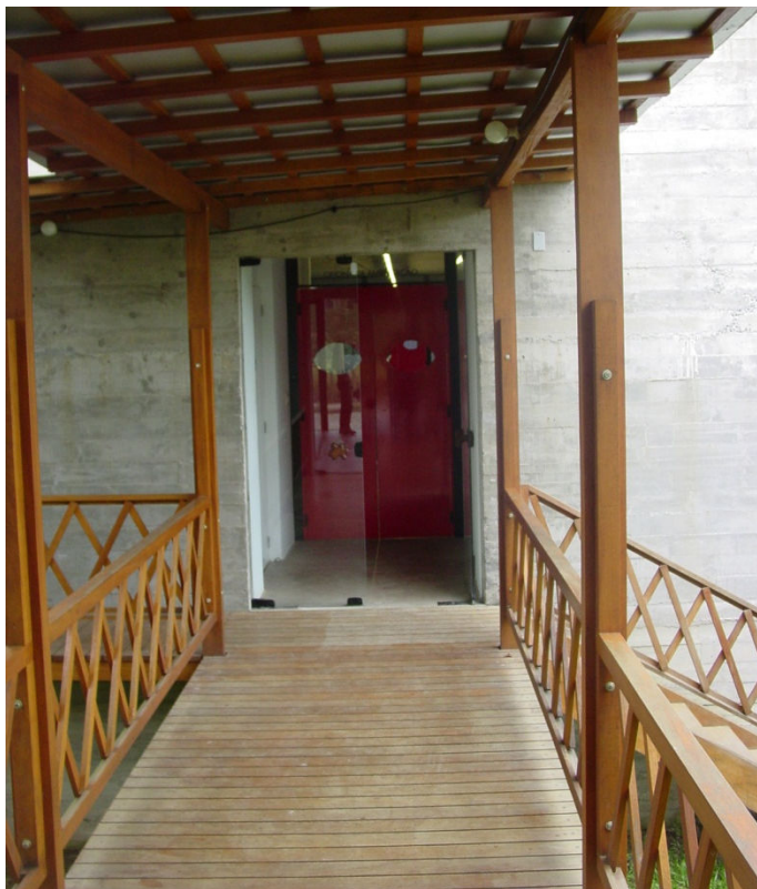
Figura 133: O gradil da passarela de madeira. Foto: acervo do autor (2009).
