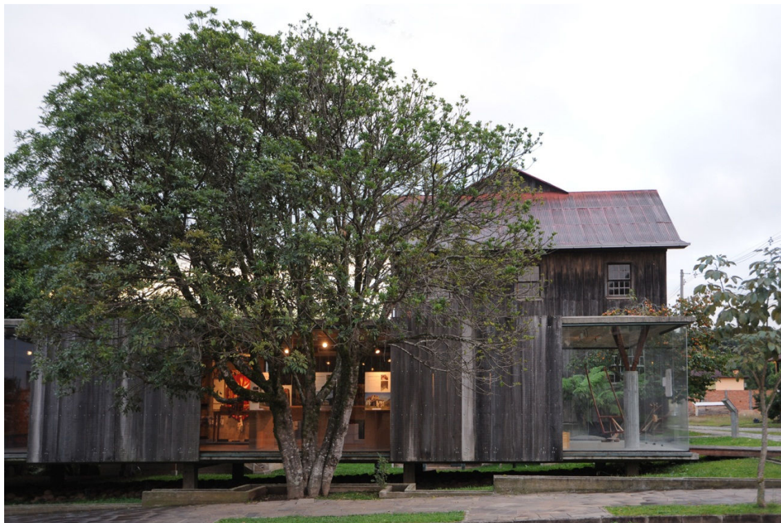
Figura 07: O Museu do Pão após o envelhecimento dos painéis móveis de madeira externos aos panos de vidro do volume expositivo. Uma das estratégias dos autores para aproximar a intervenção e as pré-existências. Foto: Eliana Assumpção (2012).
