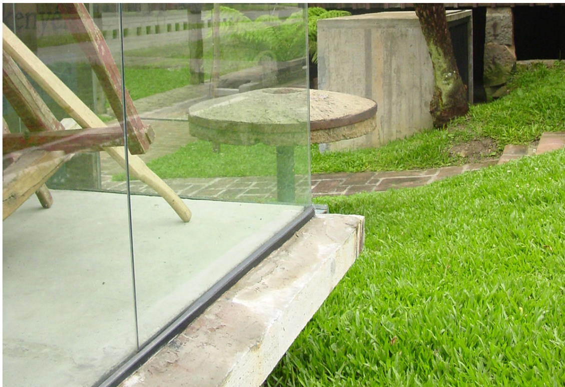
Figura 127: Os caixilhos foram fixados diretamente no concreto moldado no local. Fonte: acervo do autor (2009).
