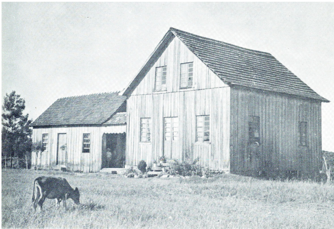
Figura 97: casa de madeira, exemplar da arquitetura da imigração italiana. Fonte: Posenato (1983).
