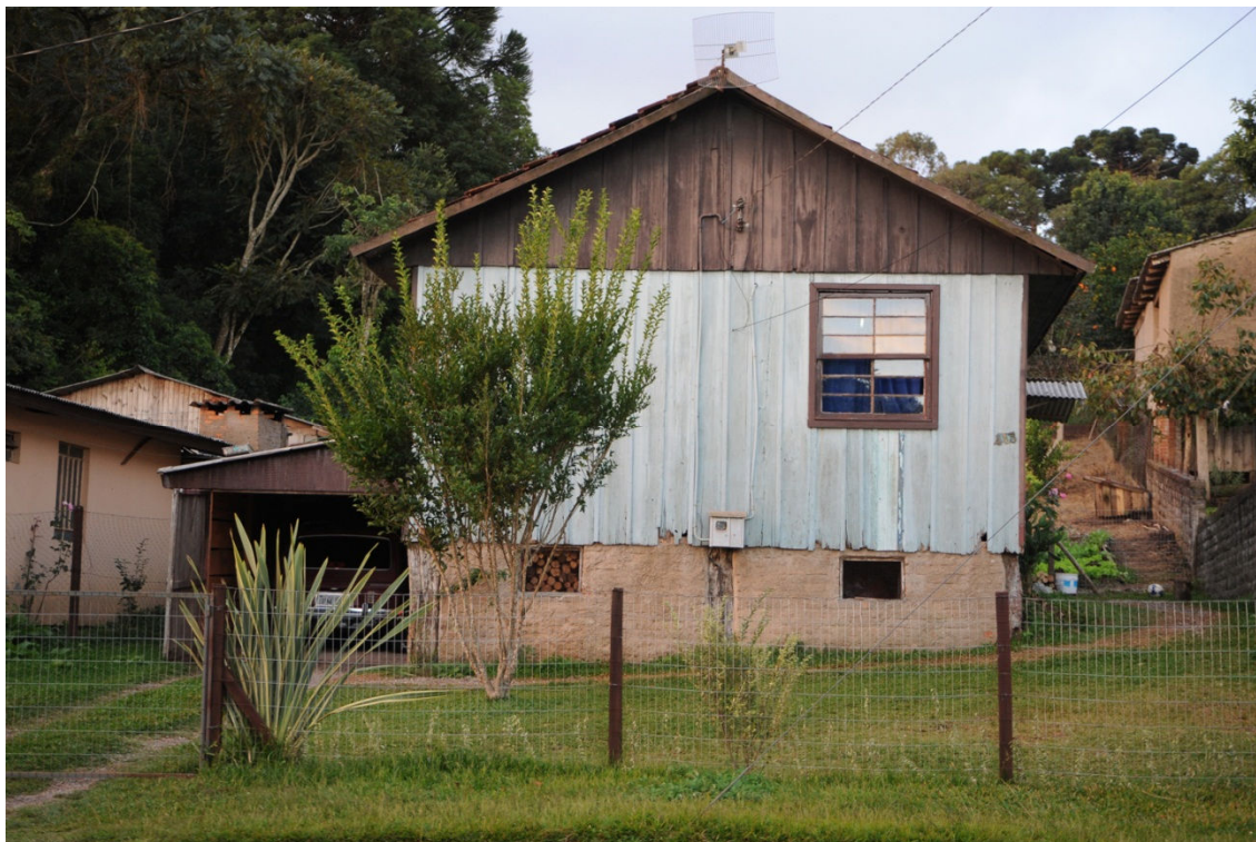
Figura 101: edificações da cidade de Ilópolis. Foto: Eliana Assumpção (2012).
