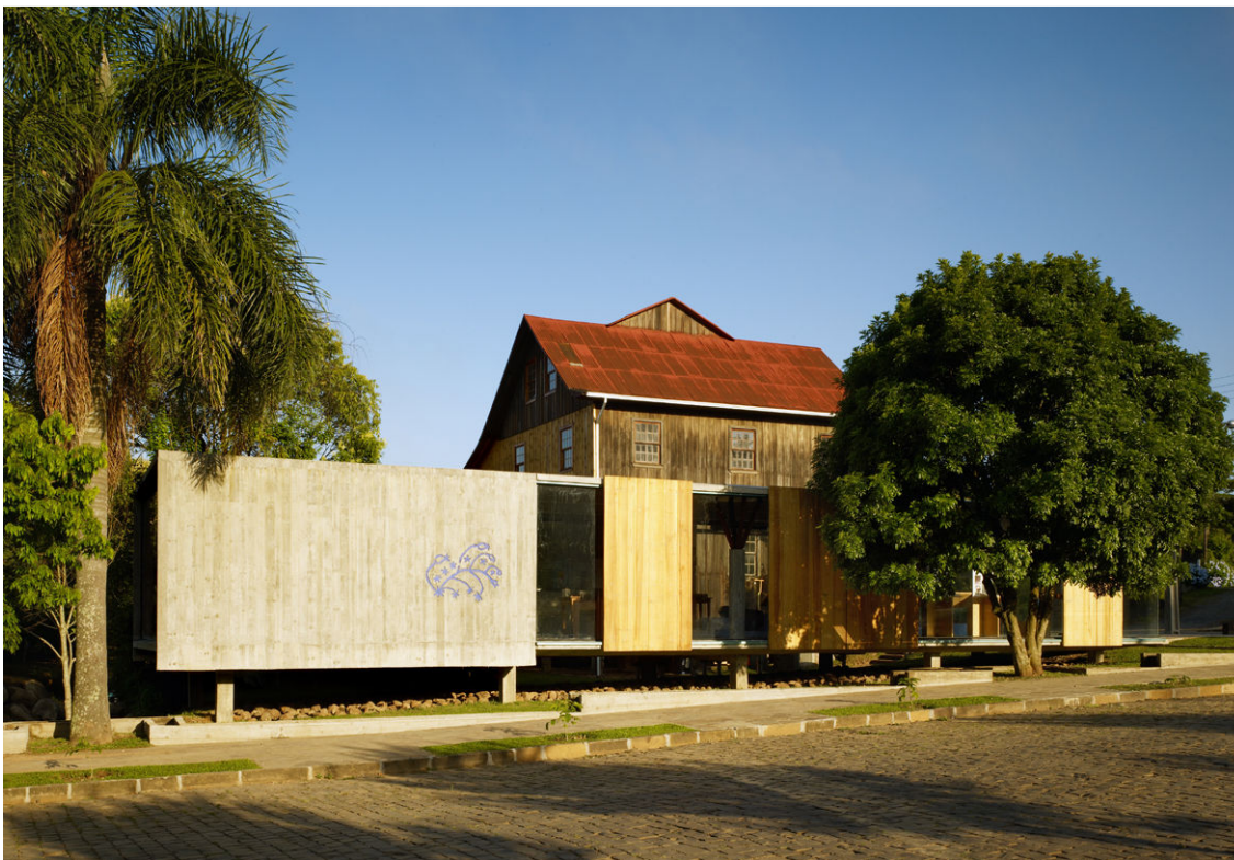
Figura 125: As novas edificações possuem mesma cota de nível. Foto: Nelson Kon (2008).
