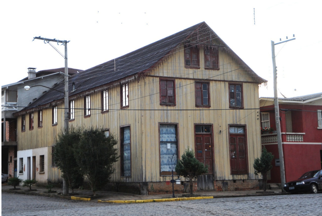
Figura 99: edificações da cidade de Ilópolis. Foto: Eliana Assumpção (2012).
