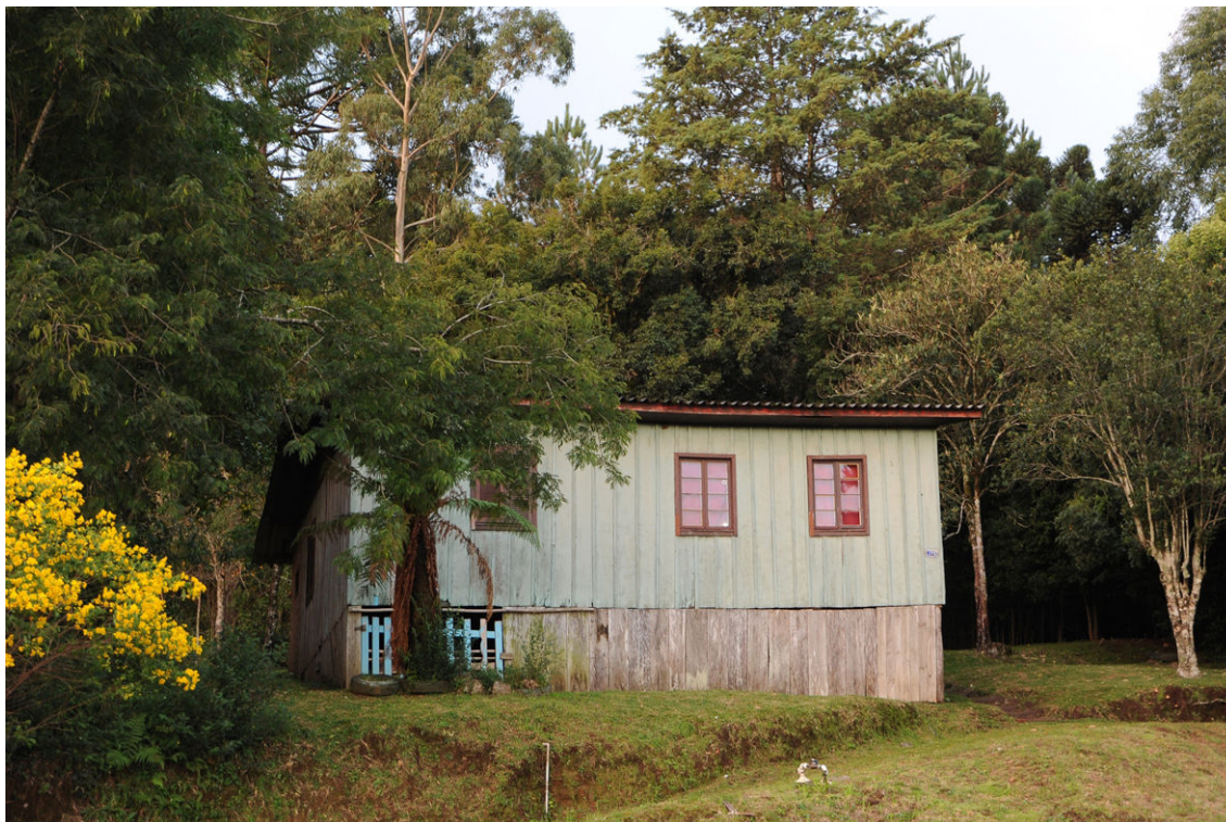
Figura 100: edificações da cidade de Ilópolis. Foto: Eliana Assumpção (2012).
