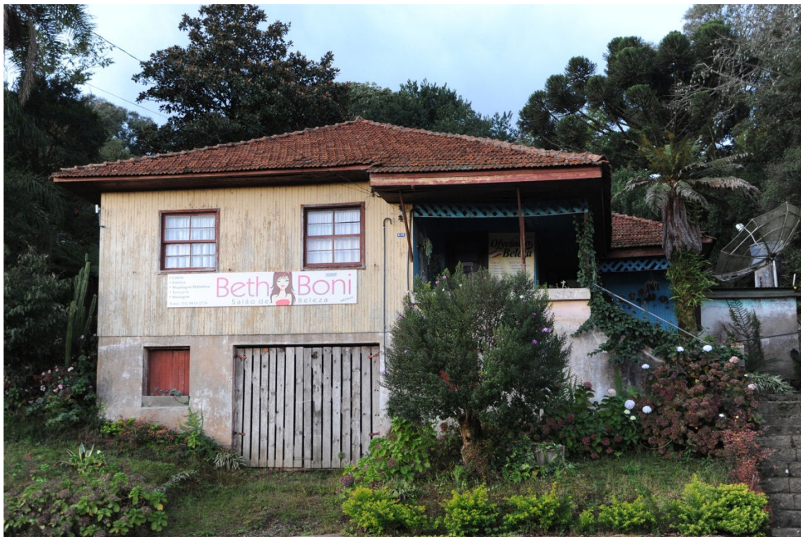
Figura 102: edificações da cidade de Ilópolis. Foto: Eliana Assumpção (2012).
