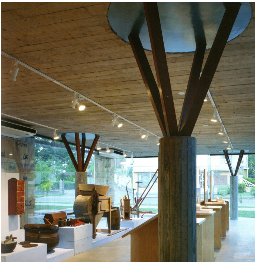
Figura 132: O pilar em “árvore”. Foto: Nelson Kon (2008).
