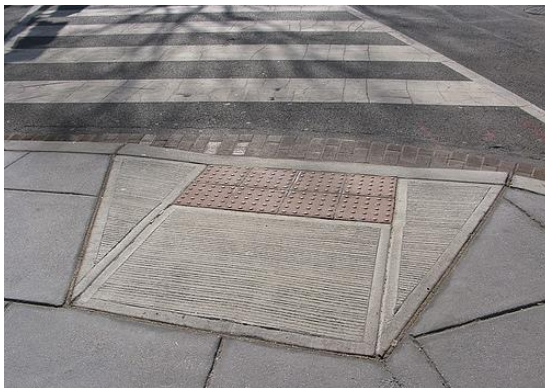
Figura 2.4: Exemplo de rampa de acessibilidade bem projetada, com inclinação correta, abas laterais e piso de alerta na base (Fonte: Google, 2012).
