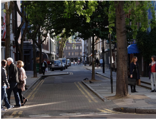
Figura 2.18: Alteração na geometria da rua utilizada para diminuir a velocidade dos veículos em Londres, Inglaterra (Fonte: Portella, 2012).
