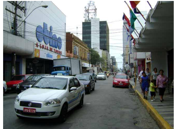
Figura 3.8: Problemas na área central de Pelotas: meios-fios altos que podem dificultar mobilidade do pedestre (Fonte: Autora, 2012).
