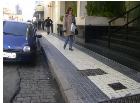
Figura 4.8: Pavimentação em bom estado de conservação na calçada da Rua General Neto, Pelotas/RS (Fonte: Autora, 2012).
