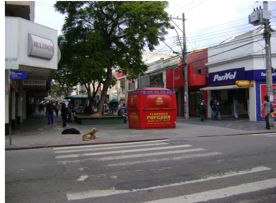
Figura 4.14: Altura do meio-fio do passeio da Rua Andrade Neves com 10 cm de altura, avaliado positivamente pelos usuários (Fonte: Autora, 2012).
