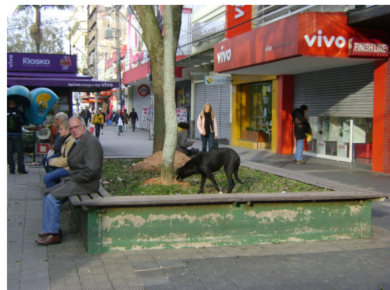
Figura 4.4: Vegetação precária e falta de manutenção dos canteiros na Rua Andrade Neves, Pelotas/RS (Fonte: Autora, 2012).
