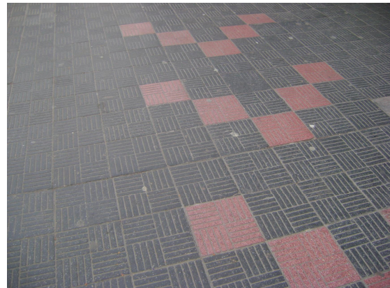
Figura 2.7: Ladrilho hidráulico nas calçadas do centro da cidade de Pelotas/RS (Fonte: Autora, 2012).
