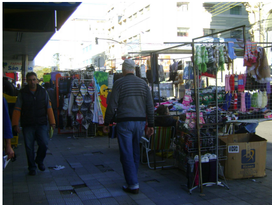
Figura 4.7: Pavimentação sem manutenção na calçada da Rua Marechal Floriano, Pelotas/RS (Fonte: Autora, 2012).
