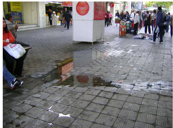
Figura 3.33: Rua Andrade Neves: sujeira e falta de manutenção do espaço (Fonte: Autora, 2012).
