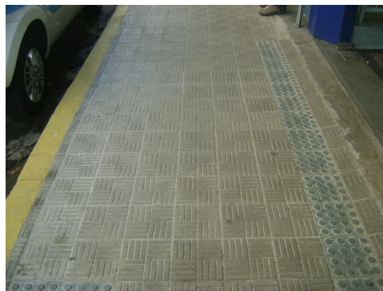
Figura 4.26: Boa conservação do piso da Rua General Neto (Fonte: Autora, 2012).
