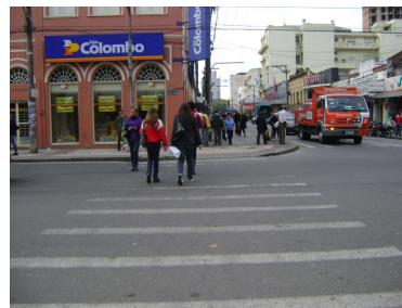
Figura 4.20: Rampa de acesso à calçada na Rua Marechal Floriano, Pelotas/RS (Fonte: Autora, 2012).
