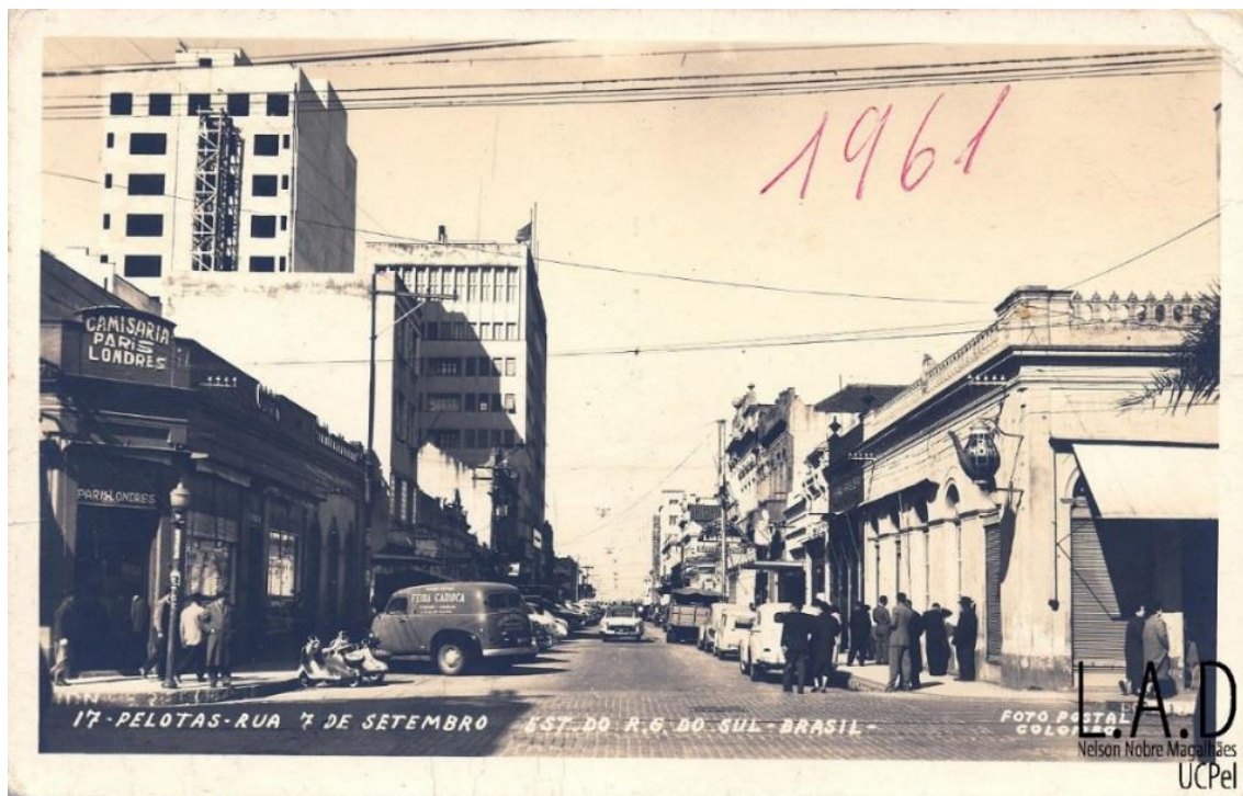
Figura 29- Fachada da loja O Bule Monstro – Rua Sete de Setembro esquina Andrade Neves. Fonte: Laboratório de Acervo Digital Nelson Nobre Magalhães - UCPel.
