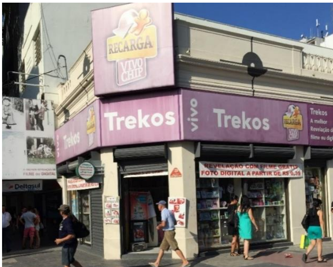
Figura 31 - Poluição visual na fachada da loja Trekos, no Calçadão de Pelotas. Fonte: Autora, 2015.
