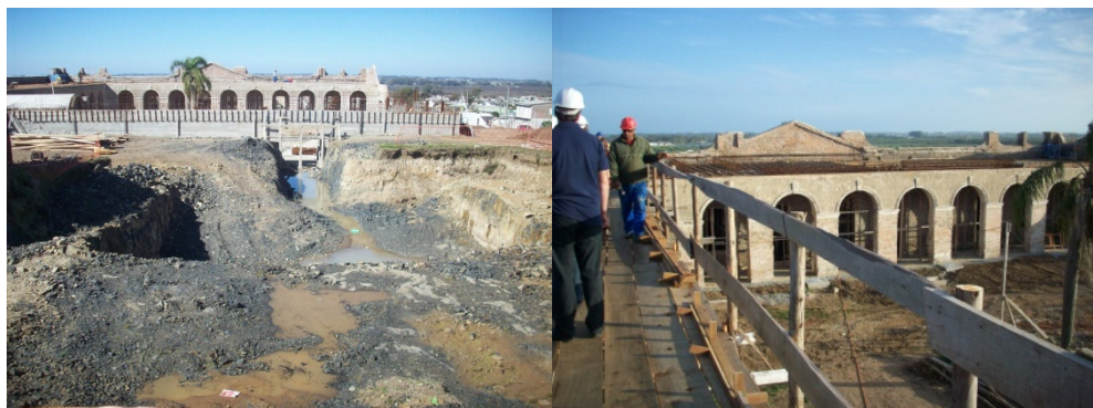
Figura 49 – Imagens da obra de restauração da Antiga Enfermaria Militar. Fonte: Fotos da autora (2013).
