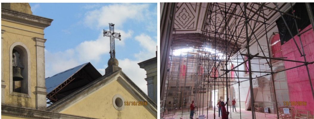
Figura 70 - Obra da Igreja Matriz, iniciada pela cobertura em junho de 2016 Fonte: Fotos da autora (outubro/2016)
