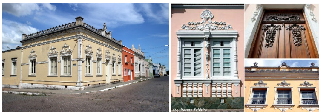
Figura 92 - Aspectos arquitetônicos de Jaguarão. Fonte: Acervo IPHAN.
