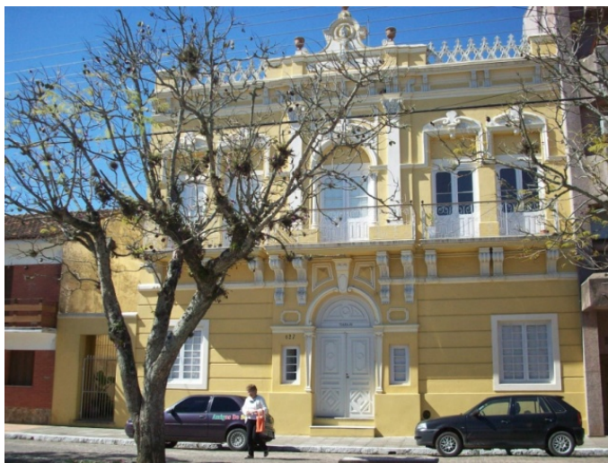
Figura 19- Edifício Tiaraju. Fonte: Foto da autora (2013).
