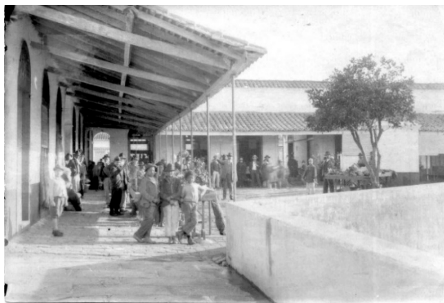
Figura 80 - Foto antiga do pátio interno do Mercado (s/ data). Fonte: Acervo IPHAN
