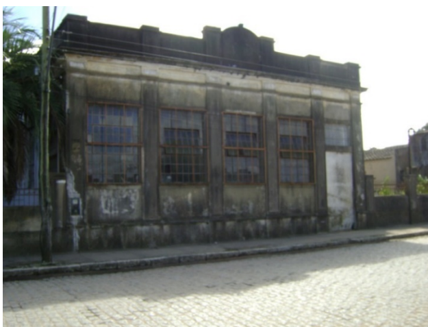
Figura 84 - Edificação da antiga Usina de Energia de Jaguarão. Fonte: Foto da autora (abril/2016).
