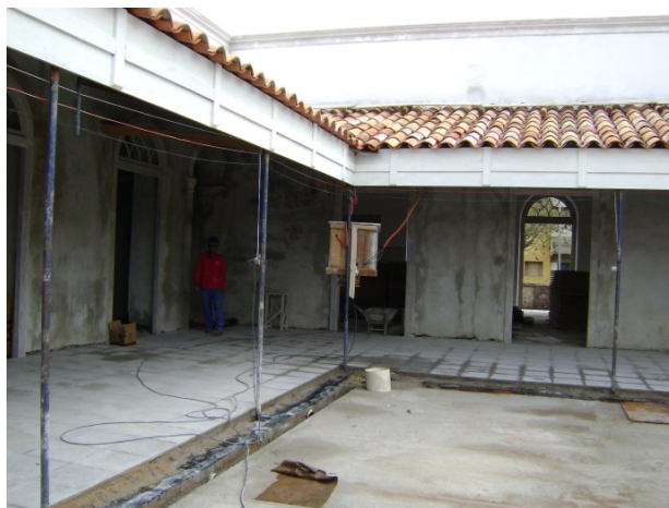
Figura 77 - Área coberta sem o elemento vertical de captação de água do telhado. (Foto de 2/10/2015) Fonte: Acervo IPHAN.
