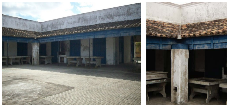
Figura 78 – Remendo no piso do pátio onde se pressupunha a existência de um poço. Ao fundo, área coberta com elemento vertical de captação de água do telhado. Fonte: Acervo IPHAN (foto anterior à obra que começou em 2014).
