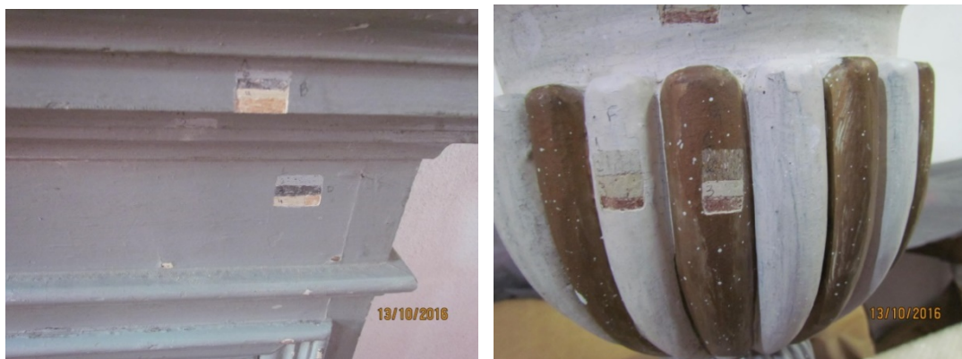
Figura 67 - Prospecção de cores em elementos de madeira do altar Fonte: Fotos da autora (outubro/2016)
