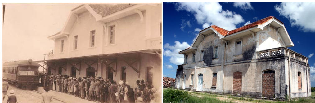
Figura 39 - Estação Ferroviária (s/data).
