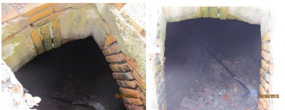
Figura 76 – Fotos da cisterna encontrada no local onde se pressupunha existir um poço. Fonte: Acervo IPHAN (foto de 20/8/2015).
