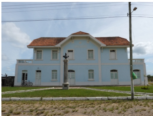
Figura 14 - Antiga Estação Ferroviária de Jaguarão Fonte: Acervo IPHAN
