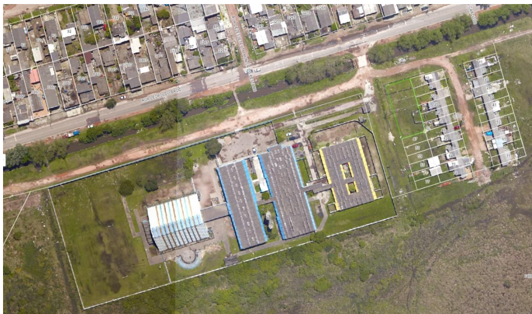
Figura 4.6 – Vista aérea do prédio que seria o CAIC de Pelotas, em ortofoto de 2015. Fonte: GEOPELOTAS, 2022c.
