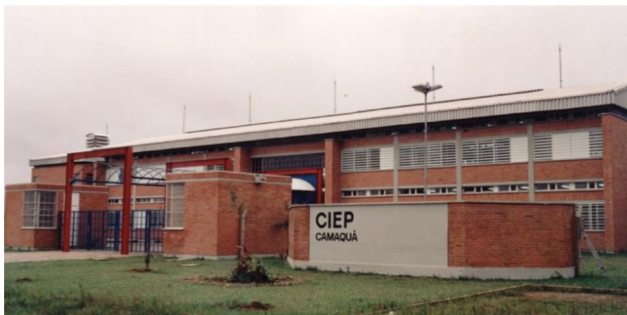
Figura 2.11 - CIEP José Adão de Assis Barbosa, em Camaquã. Fonte: RS, 2013.
