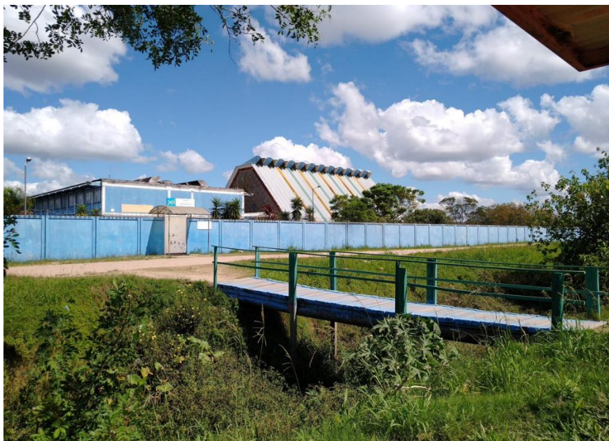
Figura 4.7 – Vista do acesso de pedestres à EMEF Francisco Caruccio, Pelotas. Fonte: AUTOR, 2022.
