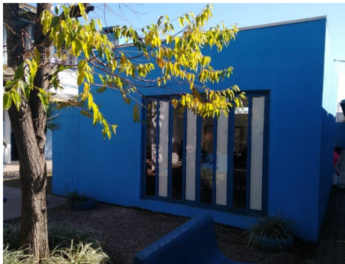
Figura 4.20 – Cozinha externa construída na EMEF Francisco Caruccio. Fonte: AUTOR, 2022.
