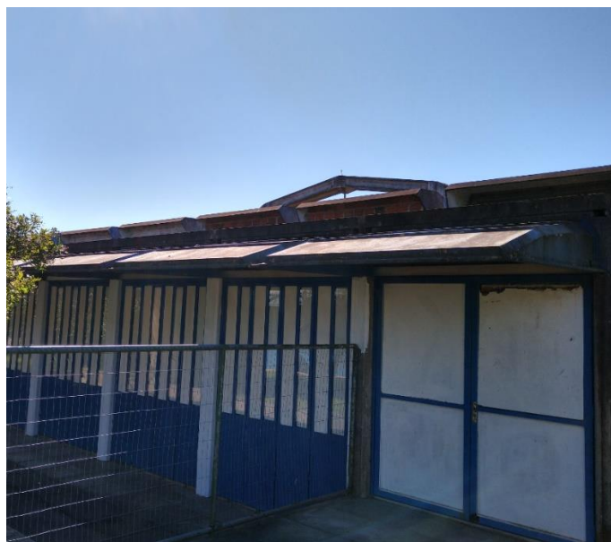
Figura 4.21 – Acesso externo do auditório da EMEF Francisco Caruccio – detalhe para o fechamento dos sheds da cobertura. Fonte: AUTOR, 2019.
