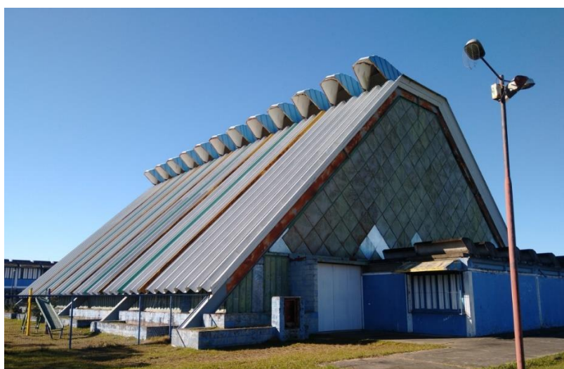
Figura 4.16 – Ginásio da EMEF Francisco Caruccio, abril de 2022. Fonte: AUTOR, 2022.
