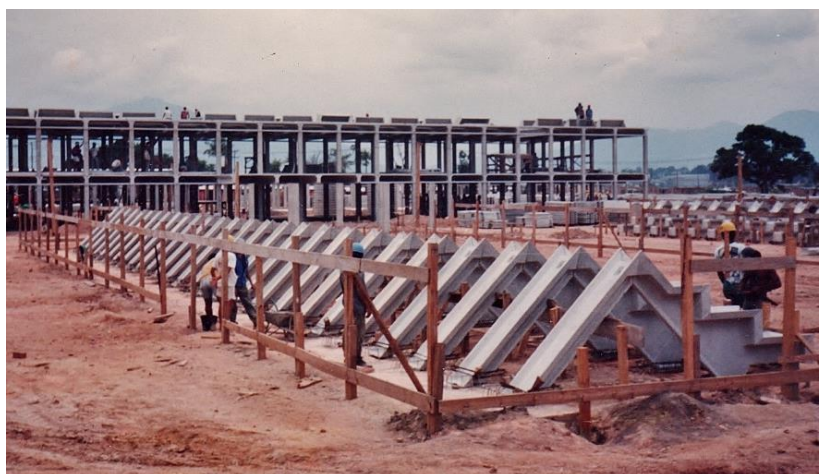
Figura 2.14 - Canteiro de obra do CAIC das Nações Unidas, no Rio de Janeiro. Fonte: LOPES, 2020.
