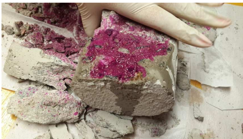
Figura 22 - Exemplo da aspersão de fenolftaleína na amostra fraturada.
