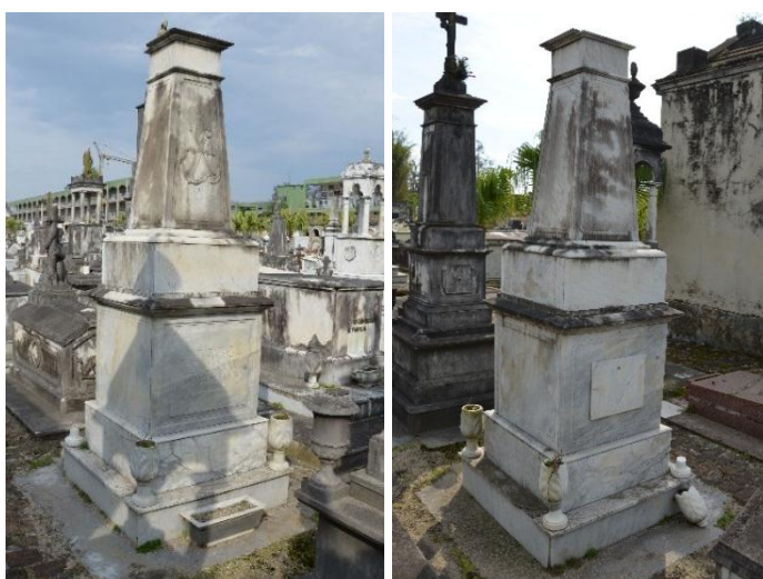
Figura 95: Torre (E) e sua porta na face posterior (D) (1911). Cemitério da Santa Casa de Misericórdia de Pelotas. Fonte: Fotos de Anderson Pires Aires. 2017.
