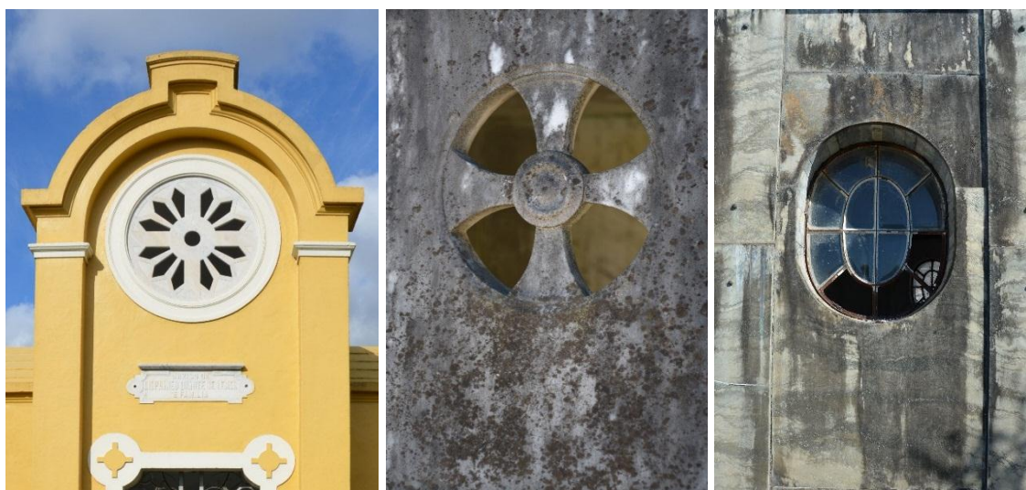
Figura 98: Janelas de mausoléus (1944; s.d.; 1962). Cemitério da Santa Casa de Misericórdia de Pelotas. Fonte: Fotos de Anderson Pires Aires. 2017.
