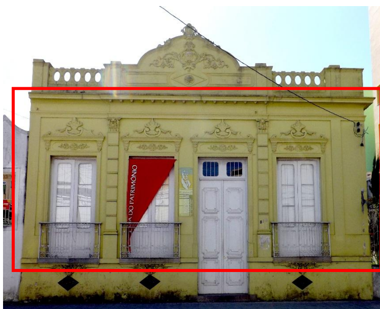
Figura 121: Corpo representado em uma fachada. Fonte: Foto de Anderson Pires Aires. 2013.
