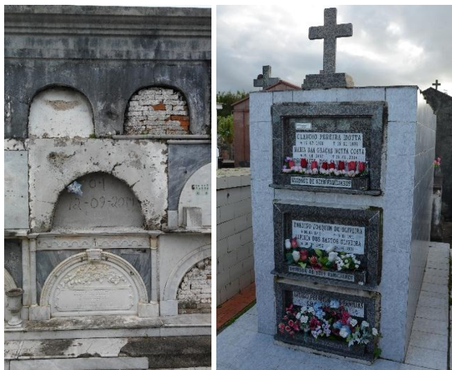
Figura 58: Catacumba (s.d.) (E) e catacumba unitária (1961) (D). Cemitério da Santa Casa de Misericórdia de Pelotas. Fonte: Fotos de Anderson Pires Aires. 2017.
