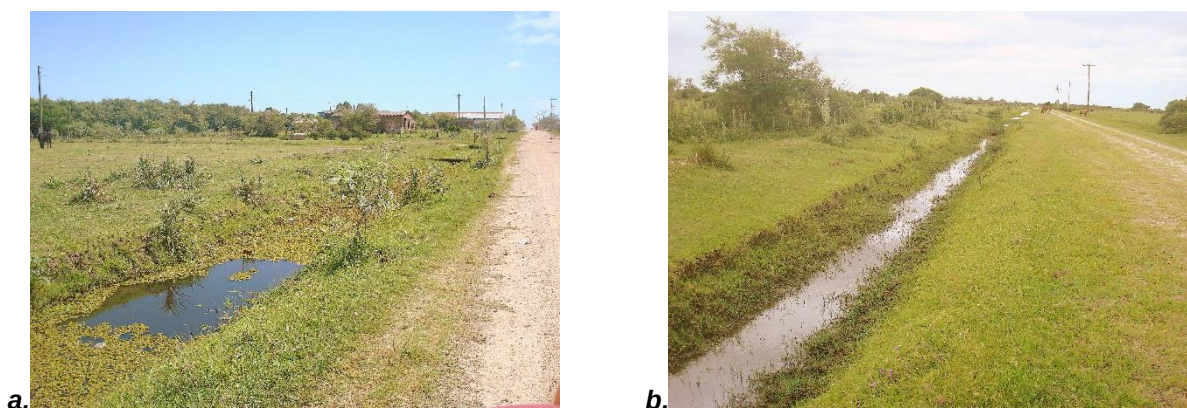
Figura 6.10: (a) e (b) Valetas à Céu Aberto (coleta de esgotos residenciais). Fonte: do Autor, 2019.
