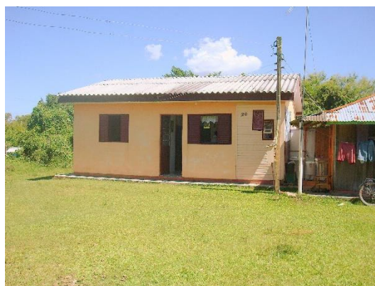
Figura 7.6: Área de Serviço transformada em Dormitório sem acréscimo de área (adaptação) – Beneficiária 10. Fonte: do Autor, 2019.
