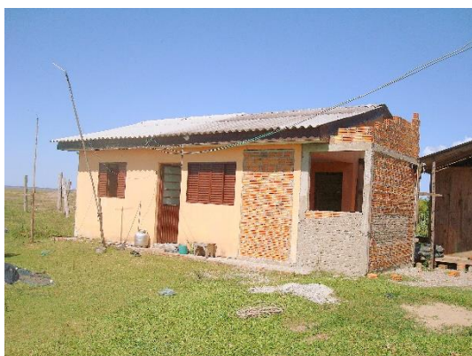
Figura 7.5: Área de Serviço transformada em Dormitório com acréscimo de área (ampliação) – Beneficiária 13. Fonte: do Autor, 2019.
