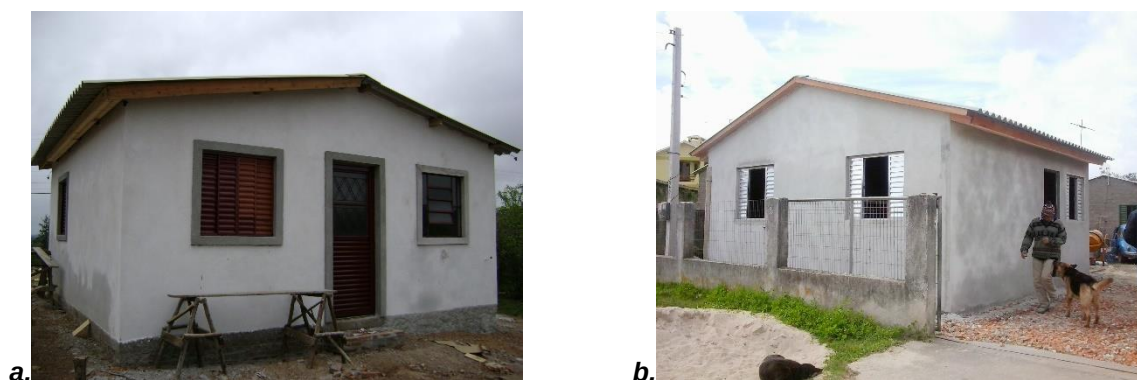
Figura 5.4: (a) e (b) Unidades Habitacionais executadas na Resolução nº 518 – Colônia Z3 – Pelotas/RS. Fonte: Acervo do Autor, 2009.
