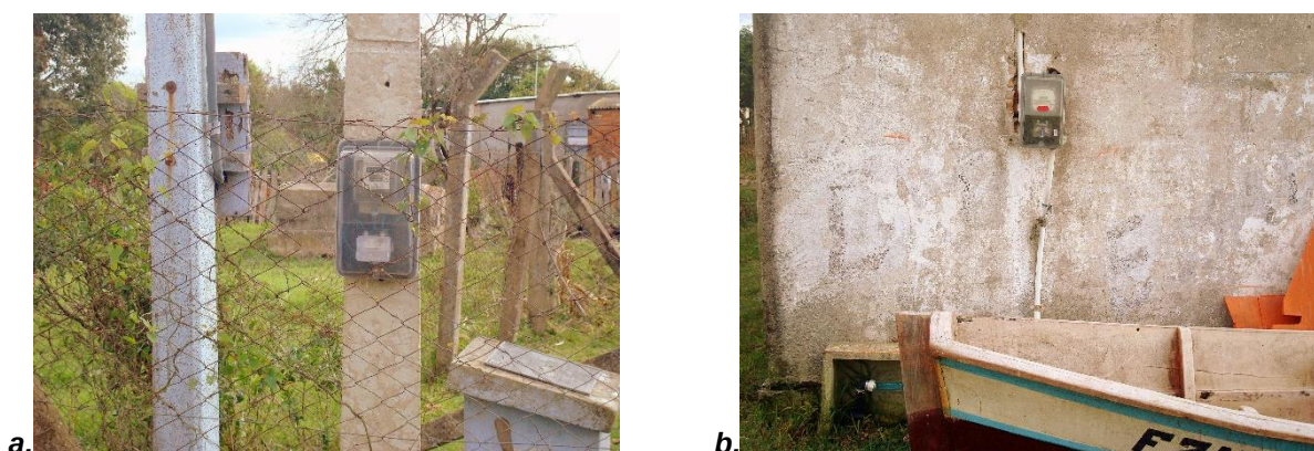
Figura 6.9: (a) e (b) Medição Individualizada de consumo de energia elétrica. Fonte: do Autor, 2019.
