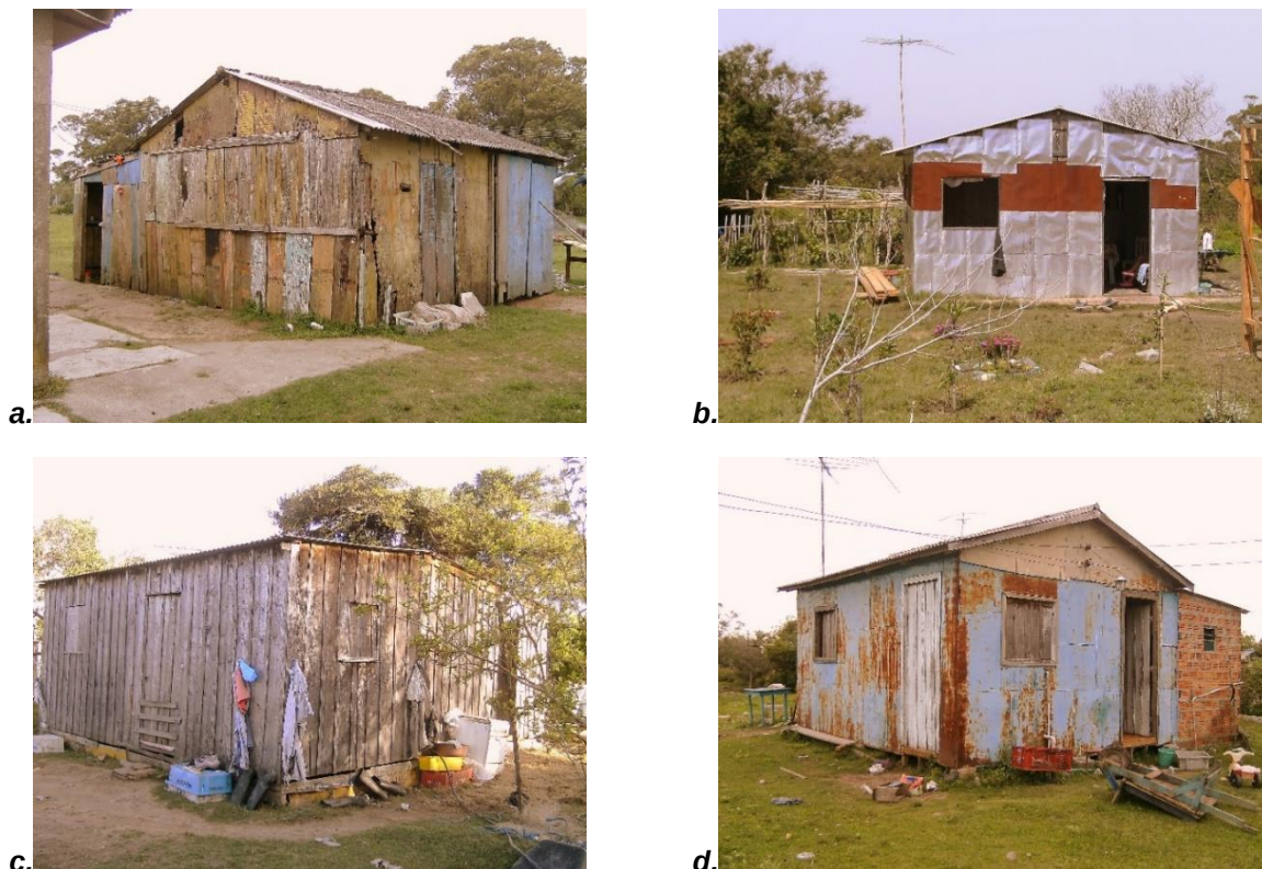
Figura 6.3: (a), (b), (c) e (d) Tipologias Habitacionais existentes – Ilha da Torotama. Fonte: do Autor, 2010.
