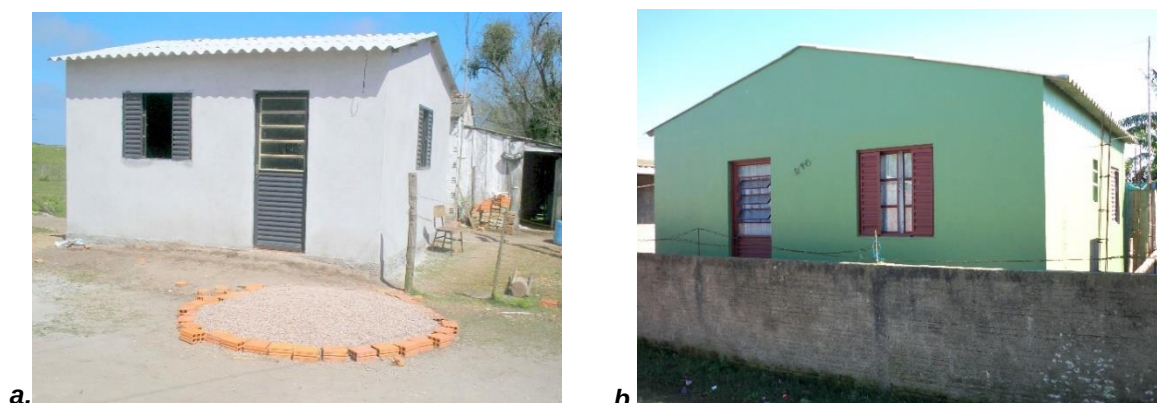
Figura 5.2: (a) e (b) Unidades Habitacionais executadas na Resolução nº 460 – Colônia Z3 – Pelotas/RS. Fonte: Acervo do Autor, 2007.
