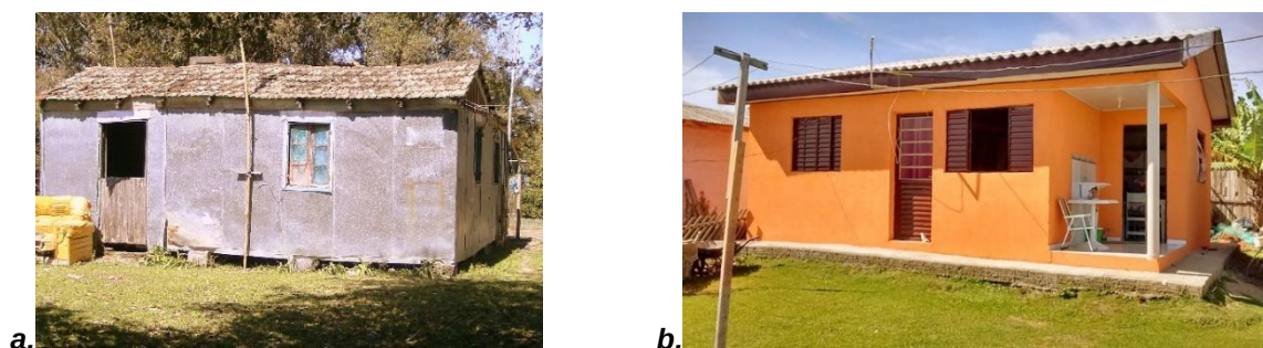
Figura 6.5: (a) Antes; (b) Depois – Intervenção resultante do PNHR – Família 01. Fonte: do Autor, 2010/17.
