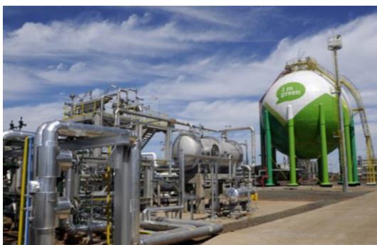
Figura 6 - Fotografia do Centro de Inovação e Tecnologia do pólo petroquímico da Braskem na cidade de Triunfo, RS. Fonte: BRASKEM, 2010.
