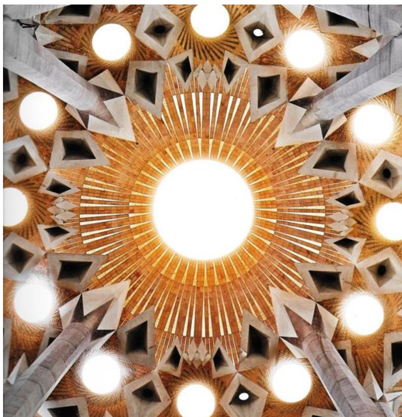
Figura 13 - Vista do teto da capela mor (ábside) no interior do Templo da Sagrada Família e algumas composições de paraboloides hiperbólicos, provocando uma apoteótica entrada de luz, valorizada ainda mais pelos filetes dourados. Foto: Marc Llimargas. Fonte: BERGÓS et al, 2011.
