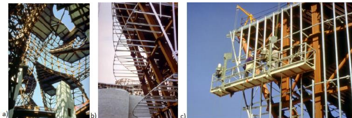
Figura 44 - a) Átrio mostrando a grade da estrutura modular; b) Curvatura horizontal da estrutura secundária; c) Estrutura terciária para fixação das chapas. Fonte: POLLALIS, 2002, p.10.
